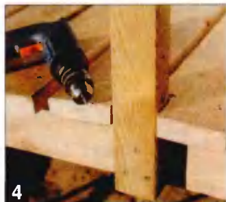
4 Стойки перил крепят к балкам на шурупах и усиливают металлическими уголками. В досках настила под стойки делают выборку.
