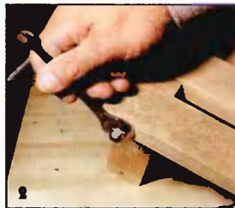
Бруски проступей и подступенков соединяют между собой на длинных шпильках и стягивают колпачковыми гайками.
