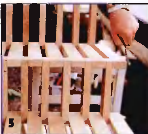
Соединения на каждом из углов ступеней – будь то передний или задний – выполняются одним и тем же способом.
