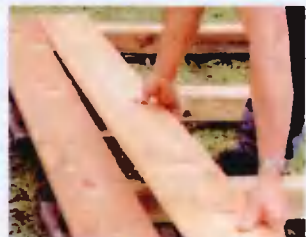
При настилке пола между досками оставляют зазоры шириной 5–10 мм.
