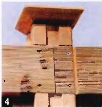
4 Головные плиты не только украшают стойки, но и защищают торцевые поверхности от дождя. Через деревянную прокладку их крепят к стойкам шурупами.
